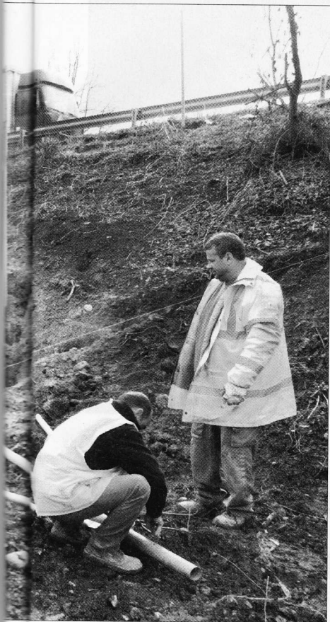
Construction d'un écoduc sur l'A64, près de Tarbes, en mars 2012. A mesure que les normes s'accroissent, les coûts flambent, les prix de vente grimpent, et les délais s'allongent.
